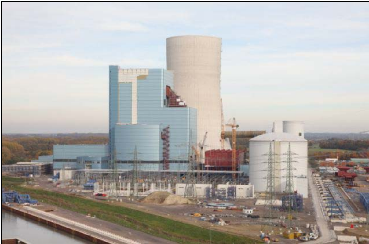
Abb. 1-1: Kraftwerk Datteln 4, Baustelle zweiten Halbjahr 2010.
