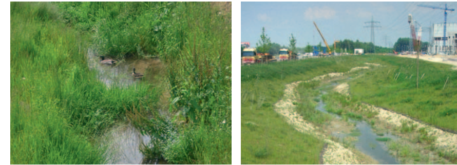
Der Ölmühlenbach verläuft auch auf dem Kraftwerksgelände. Das Umweltmonitoring untersucht Wasserqualität und Gewässergüte an drei Messpunkten.
