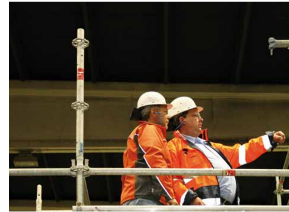
Werner Weckowski (re.) bei der Abnahme eines Gerüsts im Maschinenhaus
